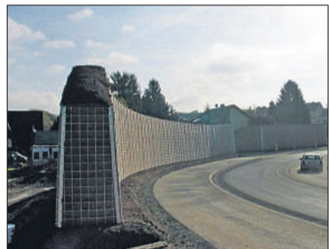
Neue Lärmschutzwand in Heiligenrode: Ganz nah an den Häusern steht die bis zu vier Meter hohe Mauer.
